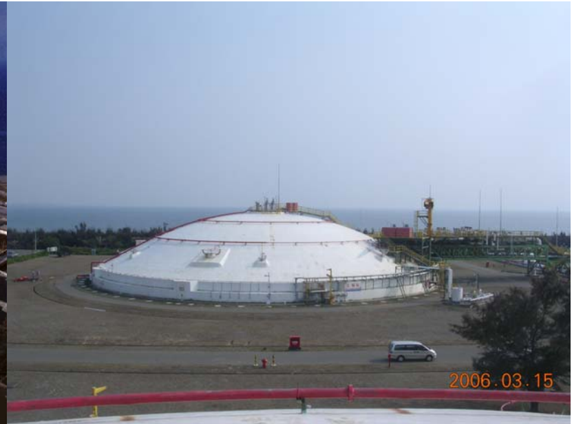
In-ground LNG tank
